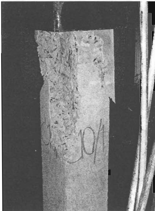
ภาพที่ 4-39 การวิบัติของเสา C10/1
