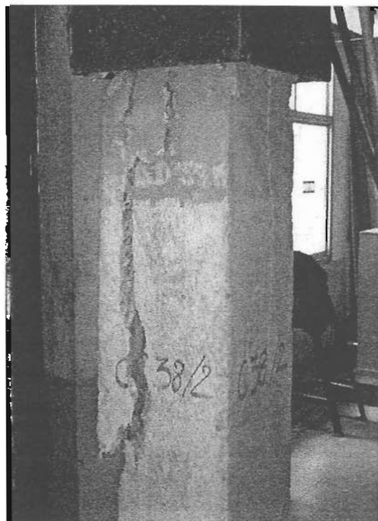
ภาพที่ 4-52 การวิบัติของเสา C38/2
