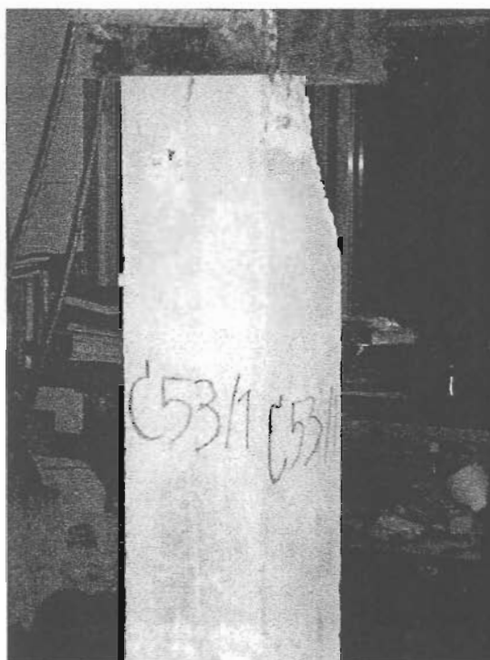
ภาพที่ 4-57 การวิบัติของเสา C53/1
