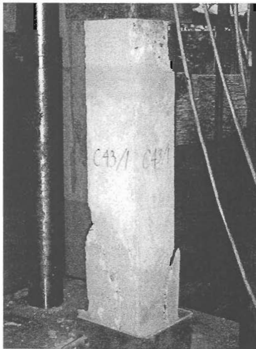
ภาพที่ 4-53 การวิบัติของเสา C43/1
