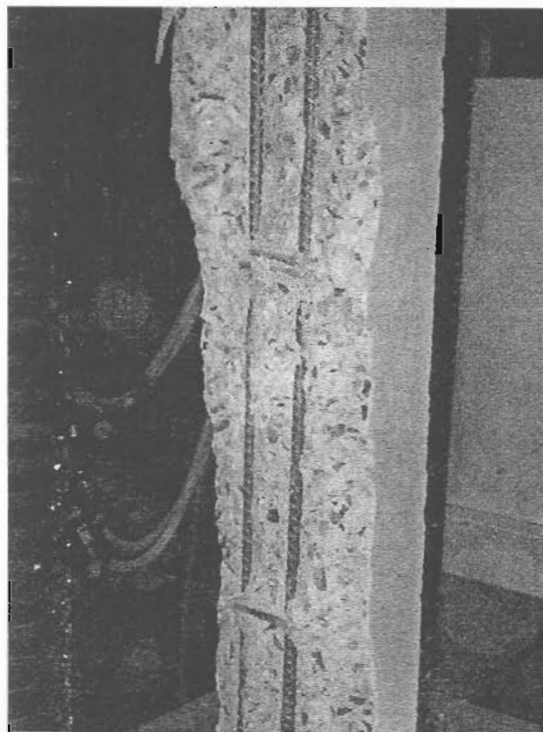
ภาพที่ 4-21. การวิบัติของเสา B19/1
