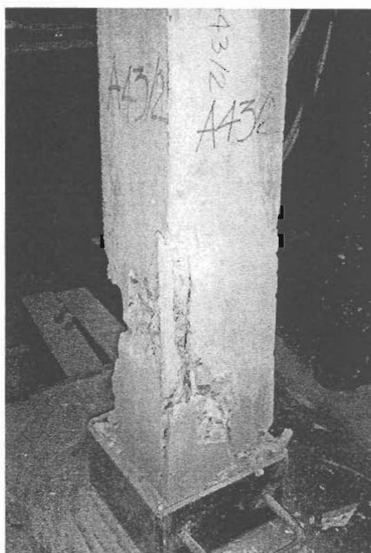
ภาพที่ 4-16 การวิบัติของเสา A43/2
