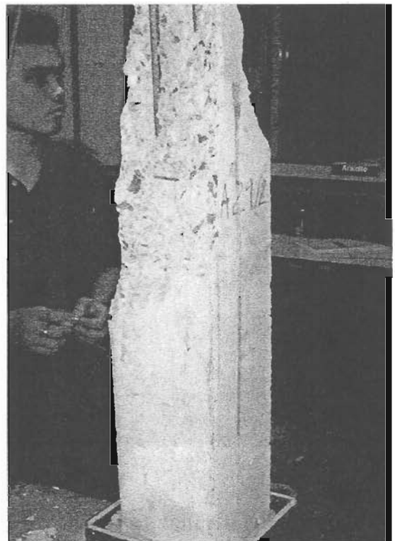
ภาพที่ 4-10 การวิบัติของเสา A29/2
