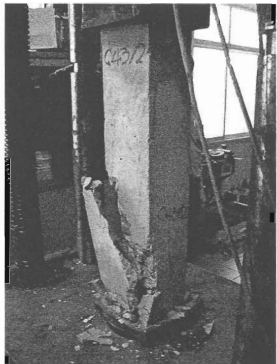
ภาพที่ 4-54 การวิบัติของเสา C43/2
