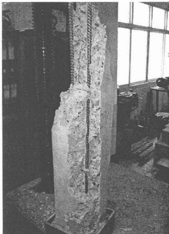
ภาพที่ 4-9 การวิบัติของเสา A29/1
