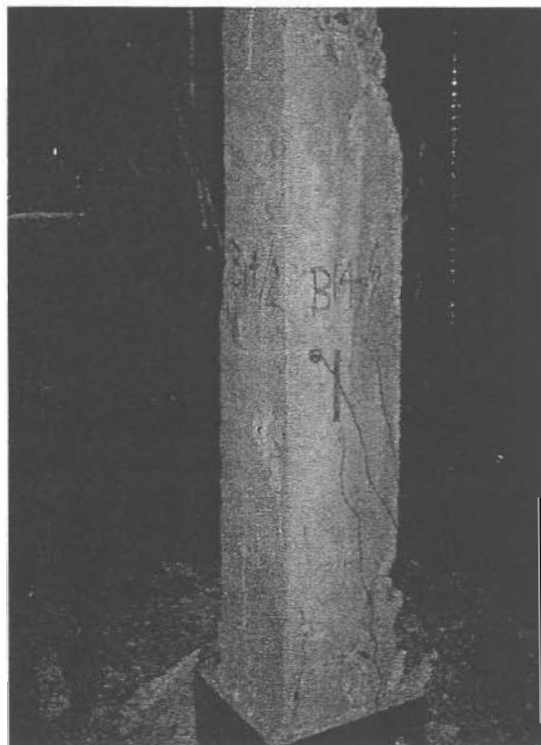
ภาพที่ 4-20 การวิบัติของเสา B14/2
