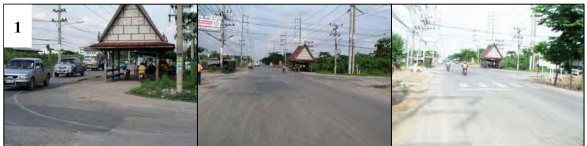
รูปที่ 4.50 สภาพปัจจุบันบริเวณทางแยก ร.พ.ศาลาया กม.12+600
