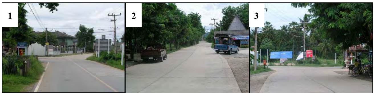
รูปที่ 4.58 สภาพปัจจุบันบริเวณทางแยก กม.6+900
