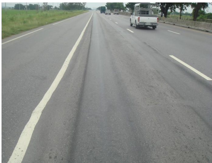
รูปที่ 2.1 สภาพผิวทางเป็นร่องล้อของหลวงหมายเลข 32 สายบางปะอิน-นครสวรรค์ กม.178+200 LT.
