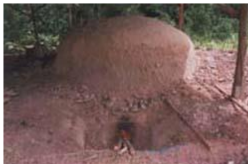
รูปที่ 2.15 ลักษณะของเตาอิฐก่อ [3]
