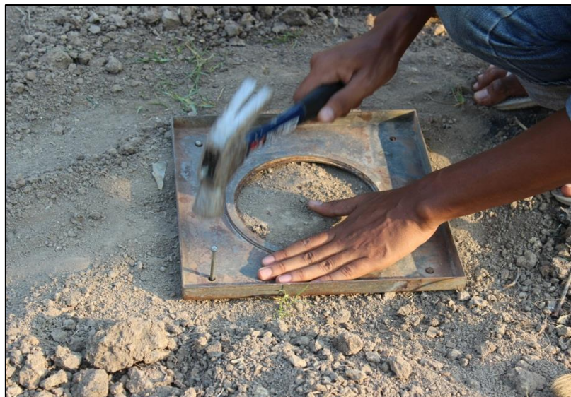
ภาพที่ 3.18 ใช้ตะปุดอัดยัดแผ่นหาความหนาแน่นให้ติดกับพื้นดิน
