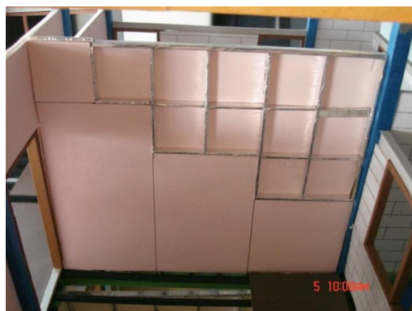
รูปที่ 4.36 แสดงผนังกันห้องที่อยู่ภายในอาคาร จะใช้ผนังเบา โครงเคร่าโลหะชุบสังกะสี กรุด้วยแผ่นยิปซัมบอร์ดหนา 12 มม. ฉาบรอยต่อเรียบ
