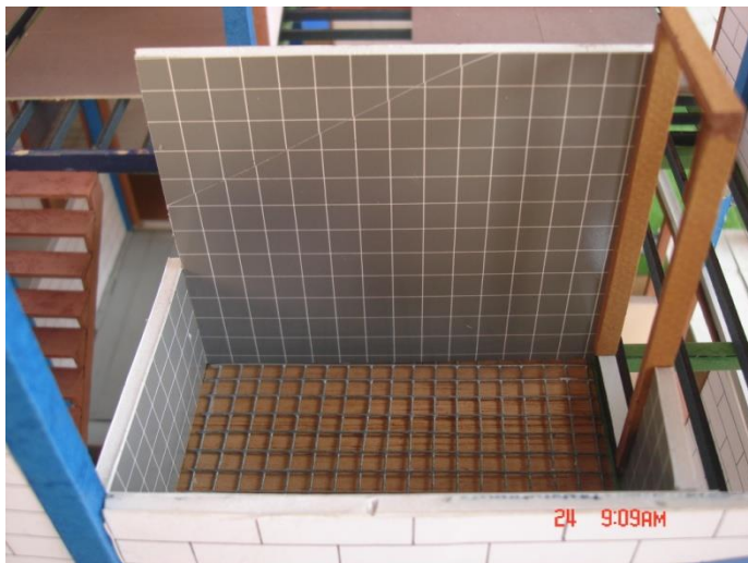
รูปที่ 4.37 แสดงการทำพื้นห้องน้ำ ซึ่งเป็นการเทพื้นคอนกรีตวางบนคานเหล็กกล่องคู่
