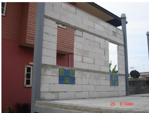
รูปที่ 4.46 แสดงผนังอิฐมวลเบา สูง 2.80 เมตร และแผ่นพื้นคอนกรีตอัดแรงที่วางอยู่บนคานโครงถักเหล็ก
