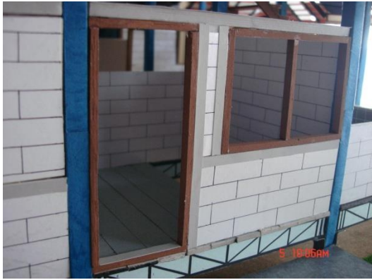
รูปที่ 4.6 แสดงผนังภายนอกอาคารใช้อิฐมวลเบา
