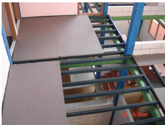
รูปที่ 4.5 แสดงดงเหล็กวางบนคานเหล็กและปิดทับด้วยแผ่นวีว่าบอร์ดหนา 20 มม.
