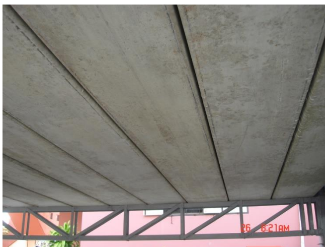
รูปที่ 4.45 แสดงคานโครงถักเหล็กรองรับแผ่นพื้นคอนกรีตอัดแรงสำเร็จรูปแบบห้องเรียบ
