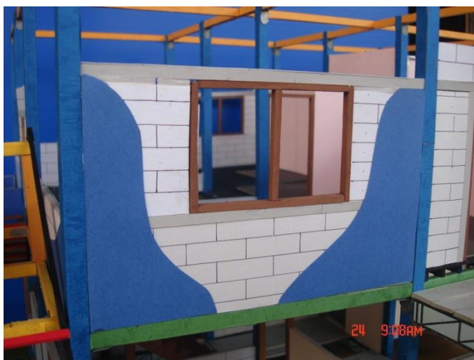
รูปที่ 4.35 แสดงผนังภายนอกอาคาร ใช้อิฐมวลเบา ขนาด 0.20 x 0.60 เมตร ฉาบปูนเรียบทาสี เพื่อป้องกันความร้อนและความแข็งแรงทนทาน
