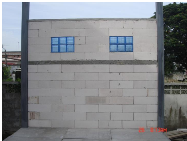
รูปที่ 4.47 แสดงผนังอิฐมวลเบา สูง 2.80 ม. และแผ่นพื้นวิว่าบอร์ค หนา 20 มม. ที่วางอยู่บนคานเหล็กกล่องคู่ 2" x 6"
