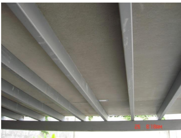
รูปที่ 4.48 แสดงแผ่นพื้นวิว่าบอร์ค หนา 20 มม. วางบนคานเหล็กกล่อง ขนาด 2" x 4" หนา 2.5 มม.
