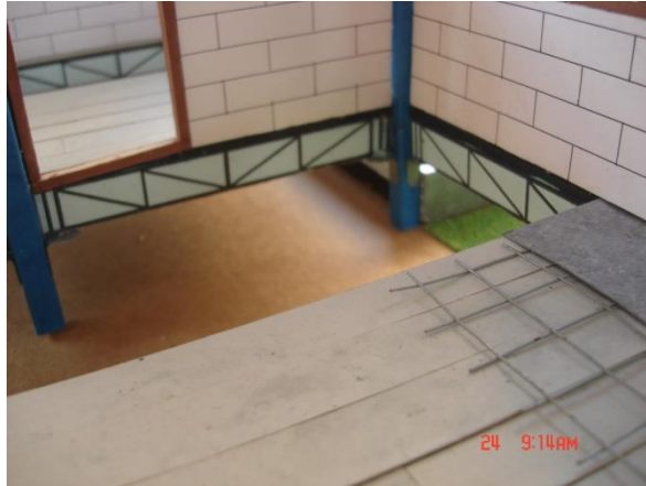
รูปที่ 4.4 แสดงการใช้แผ่นพื้นสำเร็จรูปที่ชั้นล่าง
