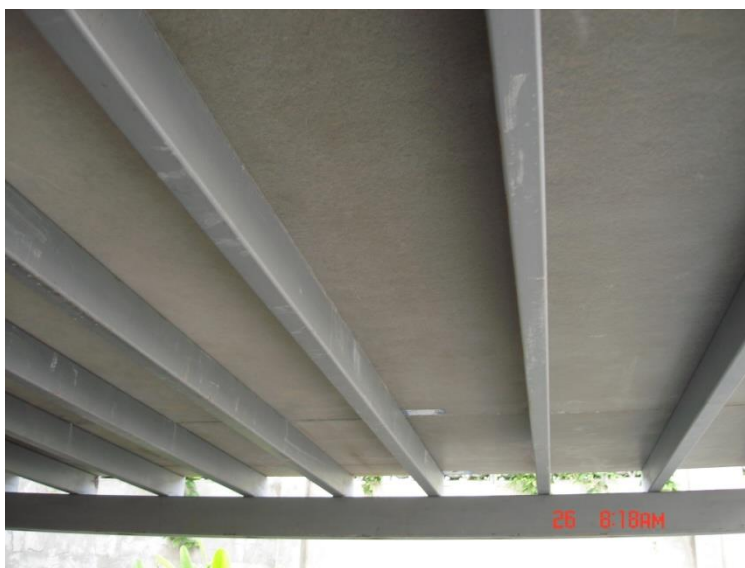
รูปที่ 4.53 แสดงคานเหล็กกล่องคู่ ยังคงมีสภาพเดิม ไม่มีการตกท้องช้าง แสดงว่าคานมีความแข็งแรง สามารถรองรับแผ่นพื้นวิว่าบอร์ดและผนังอิฐมวลเบาได้
