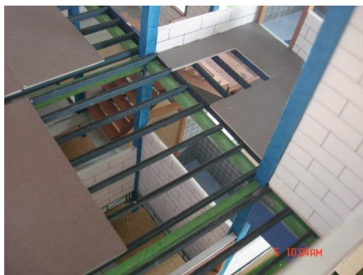
รูปที่ 4.33 แสดงการวางตงเหล็กบนคานเหล็กกล่องคู่ ระยะห่างของตง 0.40 เมตร ปิดทับด้วยแผ่นวิวบอร์ด ขนาด 1.20 x 2.40 เมตร หนา 20 มม.
