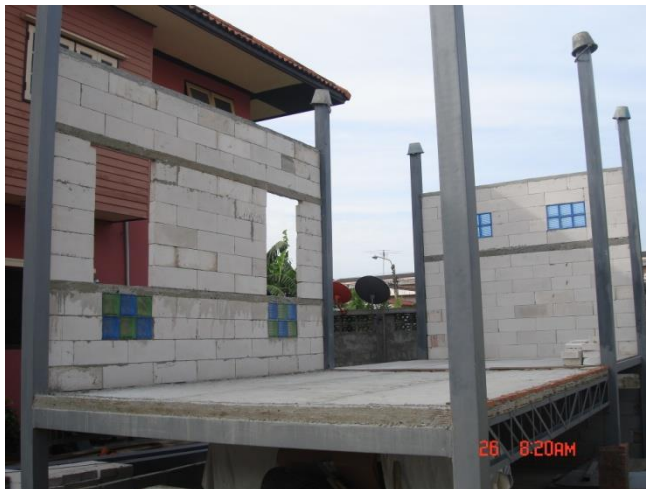
รูปที่ 4.44 แสดงการทำโครงสร้างจริง เพื่อทดสอบความแข็งแรงคานโครงถักเหล็ก และคานเหล็กกล่องคู่
