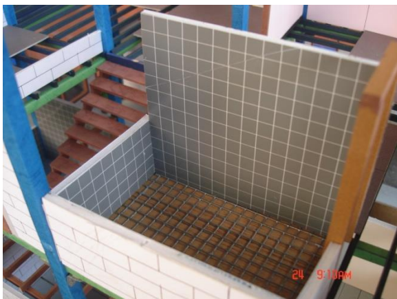
รูปที่ 4.38 แสดงผนังห้องน้ำ โดยใช้อิฐมวลเบาก่อบนพื้นคอนกรีต และกรุผนังด้วยแผ่นกระเบื้องเซรามิค
