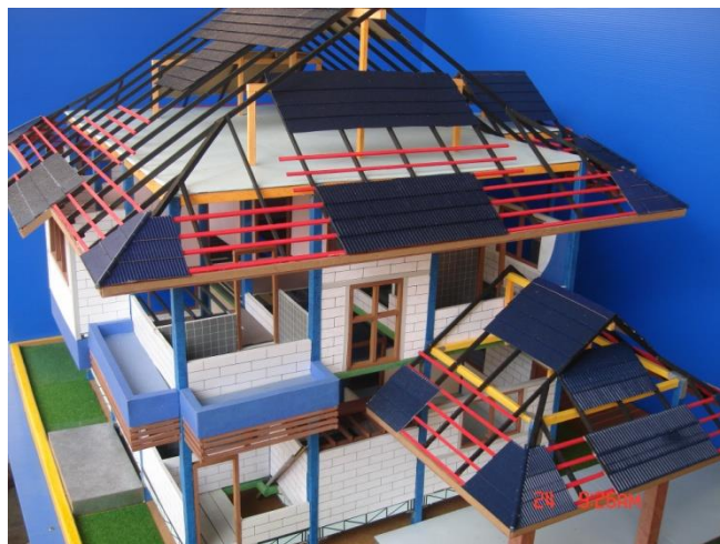
รูปที่ 4.40 แสดงโครงหลังคาอาคาร 2 ชั้น และโรงจอดรถ ซึ่งมีโครงสร้างและรูปแบบที่นิยมทำกัน ทั่วๆ ไป เพื่อความสะดวกในการก่อสร้าง
