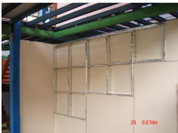
รูปที่ 4.36 แสดงผนังกันห้องที่อยู่ภายในอาคาร จะใช้ผนังเบา โครงเคร่าโลหะชุบสังกะสี กรุด้วยแผ่นยิปซัมบอร์ดหนา 12 มม. ฉาบรอยต่อเรียบ
