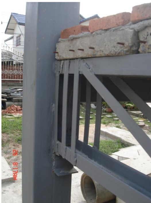
รูปที่ 4.50 แสดงการเชื่อมเหล็กฉากยึดกับเสาเหล็ก เพื่อรองรับคานโครงถัก
