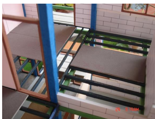
รูปที่ 4.33 แสดงการวางตงเหล็กบนคานเหล็กกล่องคู่ ระยะห่างของตง 0.40 เมตร ปิดทับด้วยแผ่นวิวบอร์ด ขนาด 1.20 x 2.40 เมตร หนา 20 มม.
