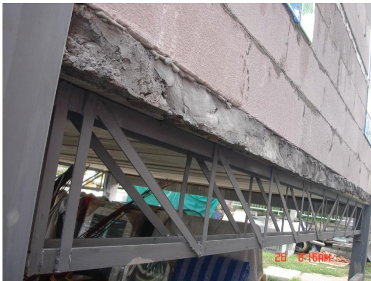
รูปที่ 4.52 แสดงคาน โครงค้ำเหล็ก ยังคงมีสภาพเดิม ไม่มีการตกท้องช้าง แสดงว่าคานมีความแข็งแรง สามารถรองรับแผ่นพื้นคอนกรีตอัดแรงสำเร็จรูปและผนังอิฐมวลเบาได้ดี
