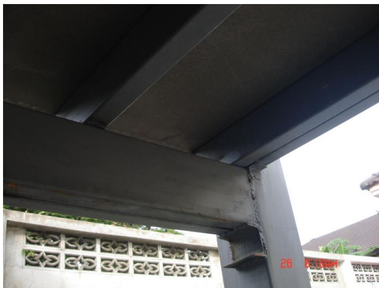
รูปที่ 4.51 แสดงการเชื่อมเหล็กฉากยึดกับเสาเหล็ก เพื่อรองรับคานเหล็กกล่องคู่
