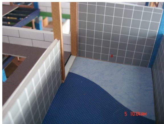
รูปที่ 4.38 แสดงผนังห้องน้ำ โดยใช้อิฐมวลเบาก่อบนพื้นคอนกรีต และกรุผนังด้วยแผ่นกระเบื้องเซรามิค
