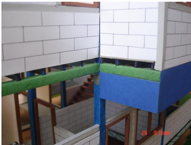
รูปที่ 4.34 แสดงโครงสร้างพื้นชั้นบนที่ยื่นออกไปจากแนวผนังอาคารชั้นล่าง
