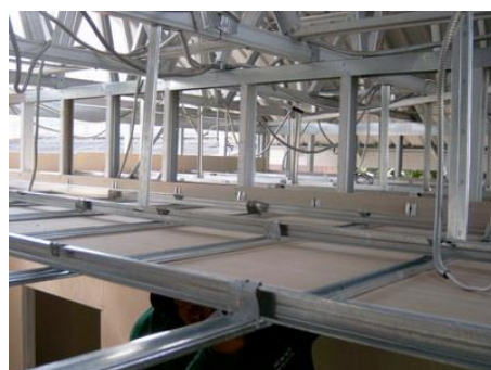
ซ่อนงานระบบไฟฟ้าไว้บนฝ้าเพดาน
