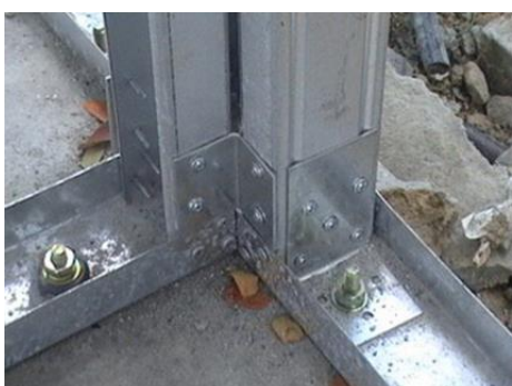
รอยต่อระหว่างโครงเหล็กอลูมิเนียมใช้น็อตเชื่อมต่อ
