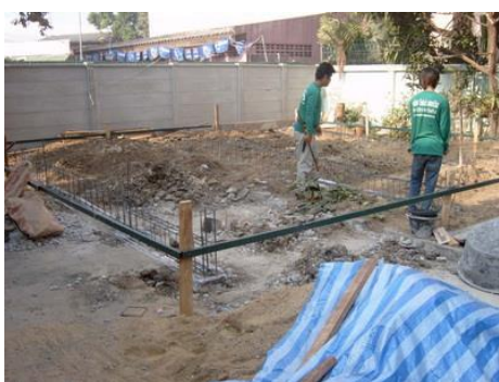
งานเตรียมฐานคอนกรีตเสริมเหล็ก
