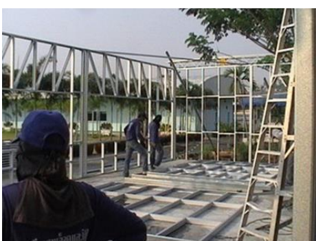
ติดตั้งผนังอลูมิเนียม
