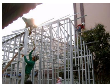
ติดตั้งโครงหลังคา
