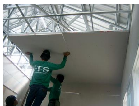
ติดตั้งฝ้าเพดาน
