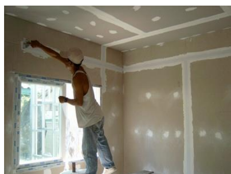
ติดตั้งผนังภายในด้วยยิปซัมบอร์ด โป้วปิดหัวน็อต
