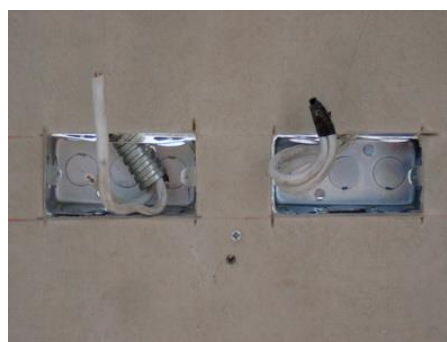
ติดตั้งผนังภายใน ซ่อนงานระบบไฟ
