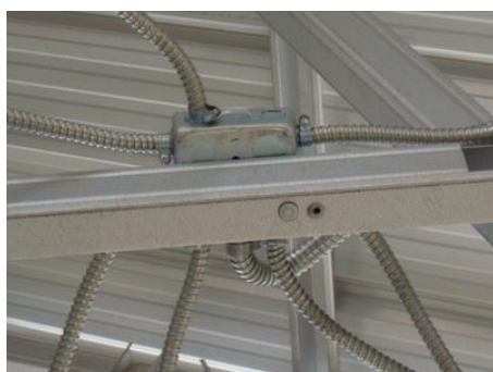
ติดตั้งงานระบบต่างๆ
