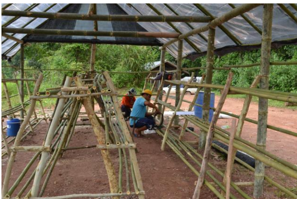
แสดงโครงสร้างของโรงเรือนปลูกพืชปลอดสารพิษ(โรงเรือนเพาะเห็ด)
