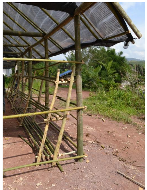
แสดงโครงสร้างของโรงเรือนปลูกพืชปลอดสารพิษ(โรงเรือนเพาะเห็ด)
