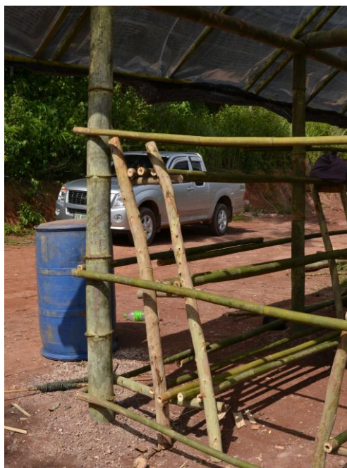
แสดงโครงสร้างของโรงเรือนปลูกพืชปลอดสารพิษ(โรงเรือนเพาะเห็ด)
