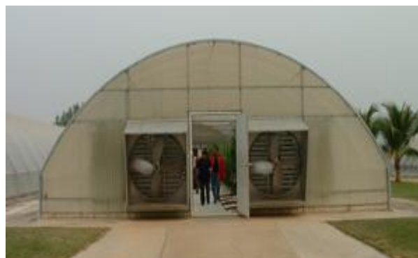
รูปที่ 2.3 โรงเรือนหลังคาหน้าจั่วแบบไม่สมมาตร
