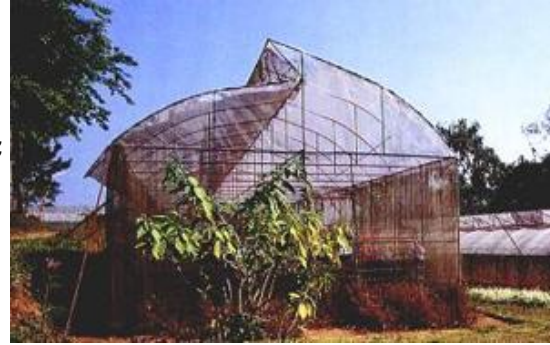
รูปที่ 2.5 โรงเรือนหลังคาครึ่งวงกลมเหลื่อม
