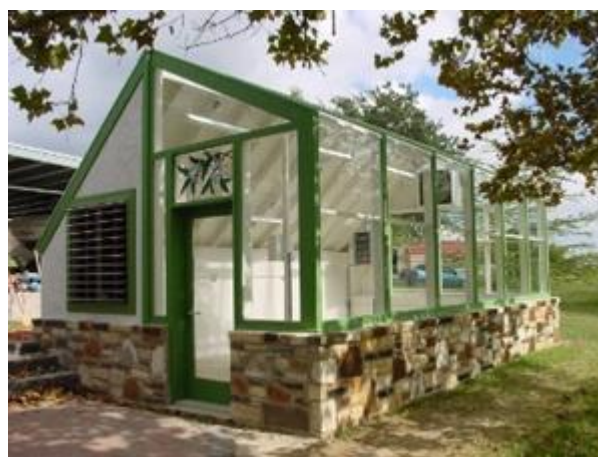
รูปที่ 2.3 โรงเรือนหลังคาหน้าจั่วแบบไม่สมมาตร
