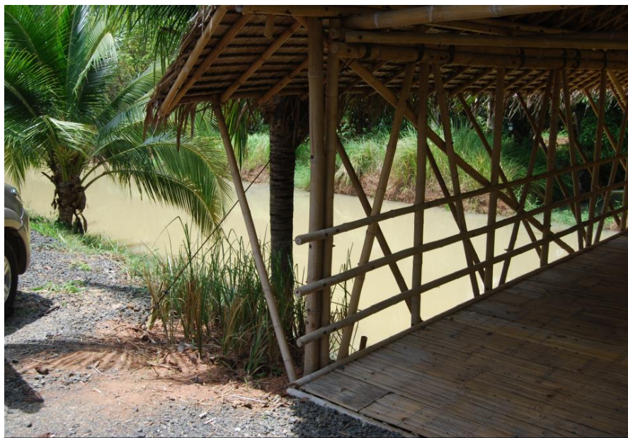
รูปที่ 4.12 แสดงสะพานข้ามคลองบริเวณสวนมะม่วงภายในสวนเกษตรของโรงเรียนมัธยมลำปลายมาศพัฒนา จังหวัดบุรีรัมย์ ที่สร้างจากไม้ไผ่ผสมผสานกับคอนกรีต
