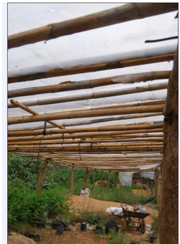
รูปที่ 4.4 แสดงโครงสร้างหลังคาอาคารชั่วคราวของเกษตรกรผู้ปลูกไม้ดอกไม้ประดับ
