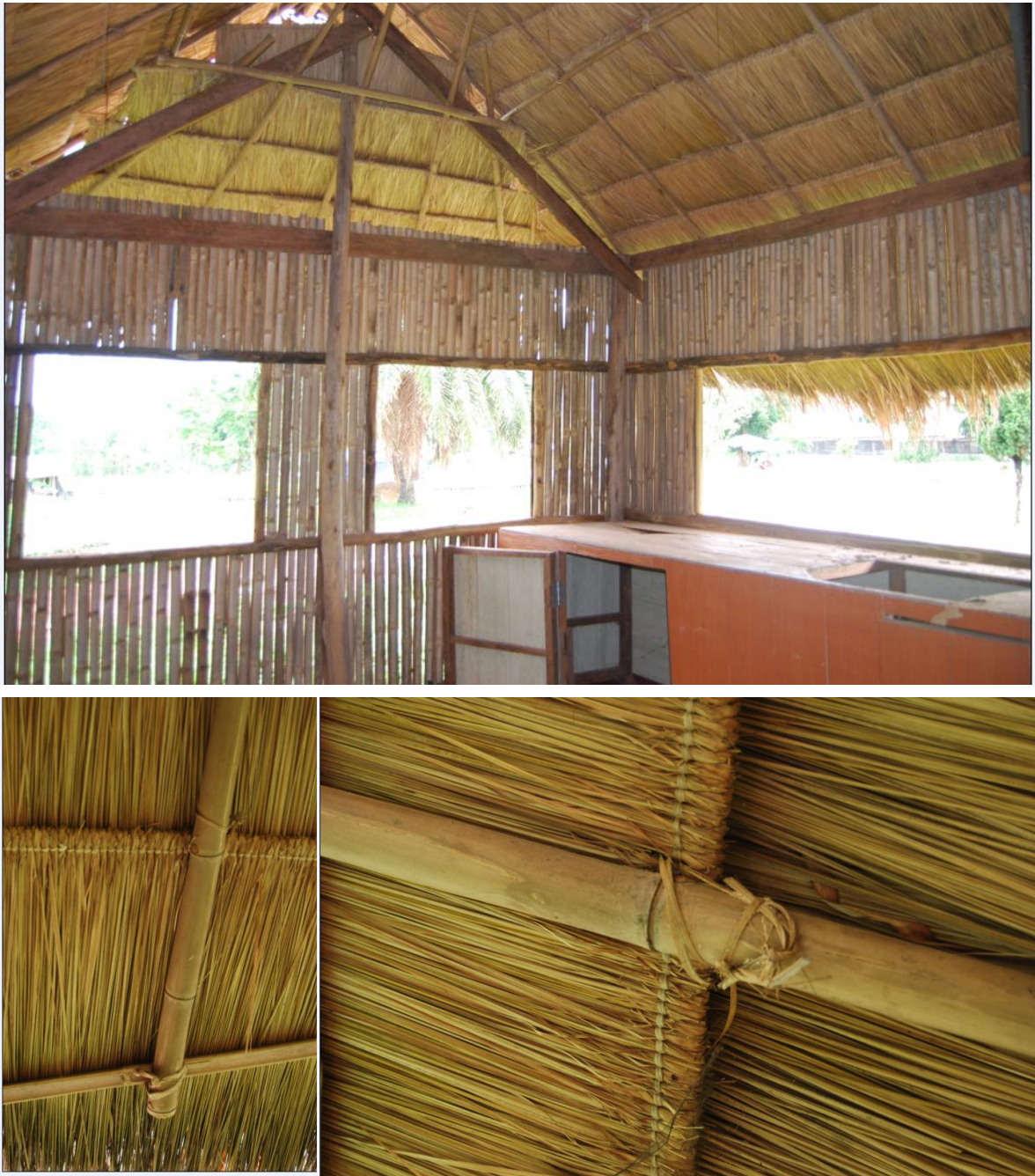
รูปที่ 4.11 แสดงภายในอาคารขายสินค้าทางการเกษตรที่สร้างจากไม้ไผ่และการมุงหลังคา
