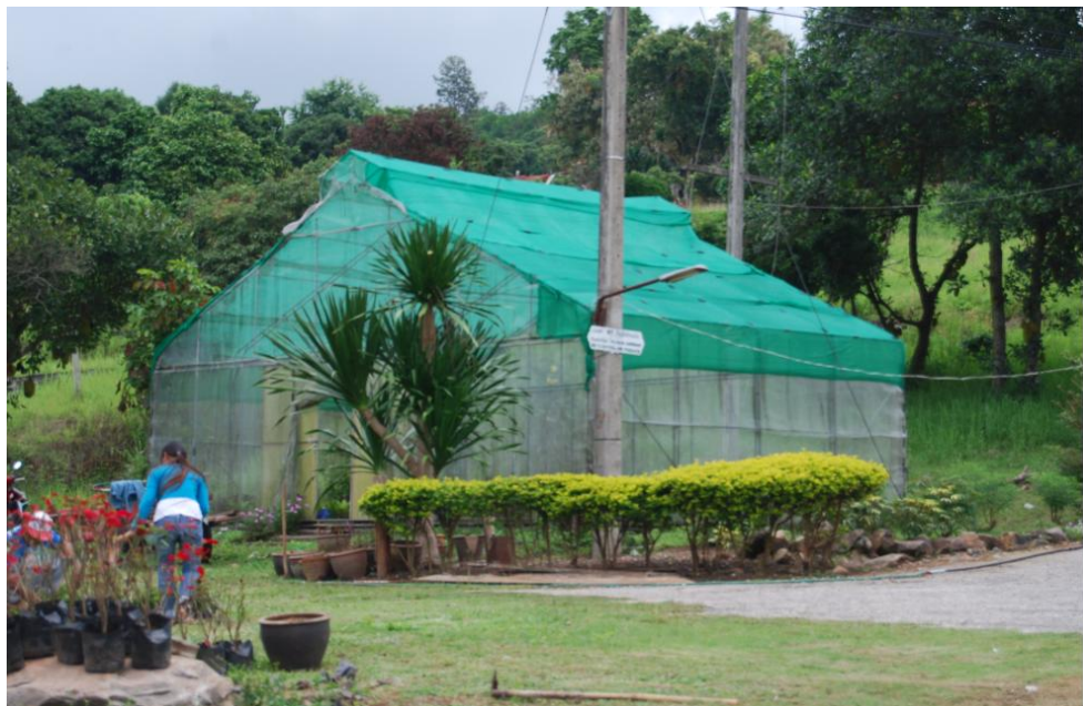
รูปที่ 4.6 แสดงโรงเรือนที่สวนปลูกไม้ดอกไม้ประดับที่ใช้โครงสร้างเหล็ก
