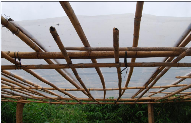
รูปที่ 4.4 แสดงโครงสร้างหลังคาอาคารชั่วคราวของเกษตรกรผู้ปลูกไม้ดอกไม้ประดับ
