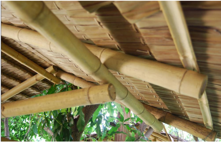
รูปที่ 4.16 ภาพแสดงรายละเอียดการยึดโครงสร้างหลังคาของศาลาพักผ่อนชั่วคราวภายในสวนมะม่วงในสวนเกษตรของโรงเรียนมัธยมลำปลายมาศพัฒนา จังหวัดบุรีรัมย์ ที่สร้างจากไม้ไผ่
