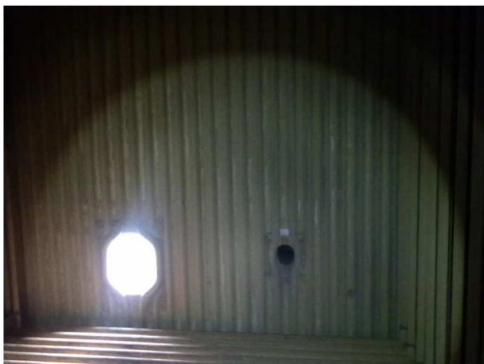
รูปที่ 1.1 ลักษณะท่อผนังภายในหม้อน้ำ
