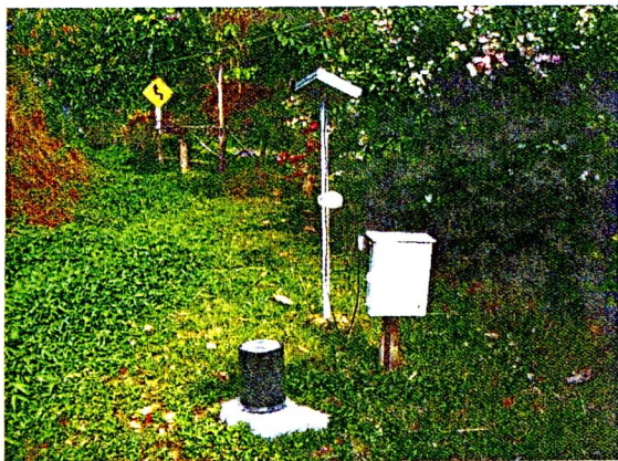
สถานีน้ำฝนที่สถานีควบคุมไฟฟ้า ดอยภูคา
