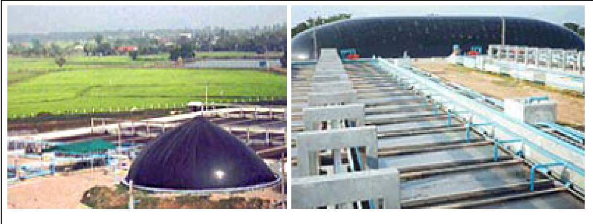
รูปที่ 3.9 บ่อหมักไร้ออกซิเจนแบบเร็วแบบ H-UASB
