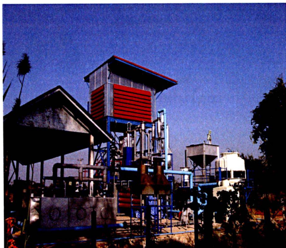
รูปที่ 2.3 โรงไฟฟ้าชีวมวลต้นแบบขนาด 100 kW ที่มหาวิทยาลัยเทคโนโลยีสุรนารี
