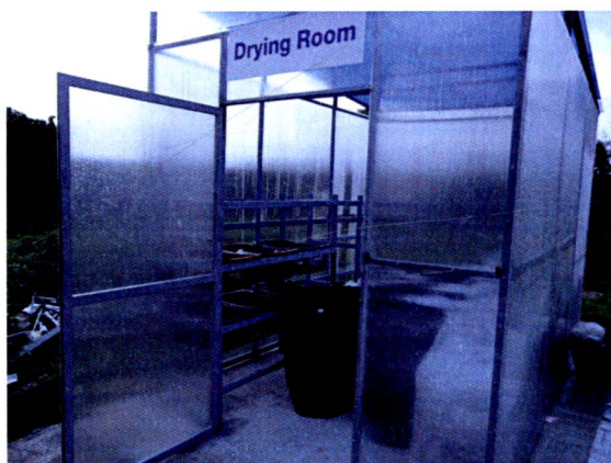
รูปที่ 4.6 การออกแบบและพัฒนาห้องอบแห้ง
