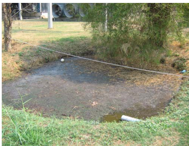
ภาพที่ 12 บ่อเกรอะสำหรับพักน้ำเสีย
