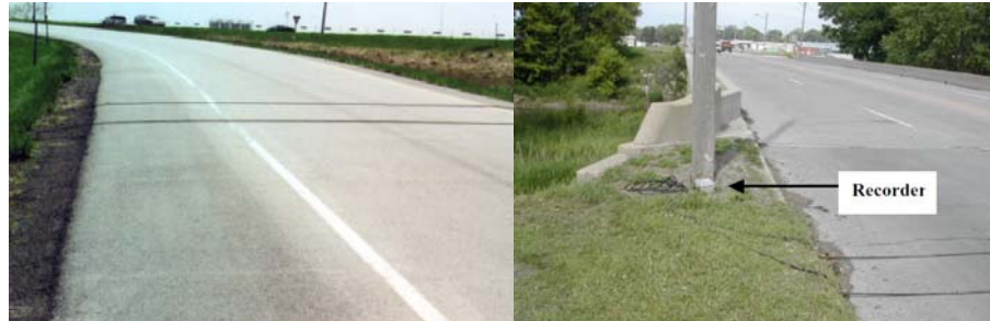
รูปที่ 2.3 อุปกรณ์และการติดตั้ง Pneumatic Road Tube บนผิวถนน
