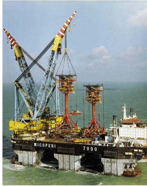
รูปที่ 2.3 ตัวอย่างการติดตั้งโครงสร้างนอกชายฝั่งทะเลขนาดเล็กแบบเสาเดี่ยวที่มีค้ำยัน [10]
