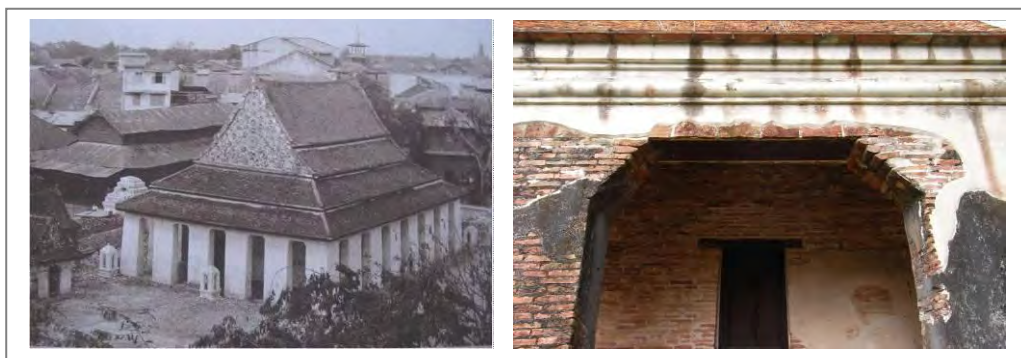
ภาพที่ 78 พระอุโบสถวัดสัมพันธวงศ์ กรุงเทพฯ มีช่องเปิดแบบคานเฉียง, ช่องเปิดของพระอุโบสถวัดศิริวรรณवास
