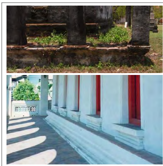
ภาพที่ 93 ฐานสองชั้นของพระอุโบสถวัดโรง อ.กระแสดินธุ์ และพระอุโบสถวัดโพธิ์ปฐมาวาส อ.เมืองสงขลา
