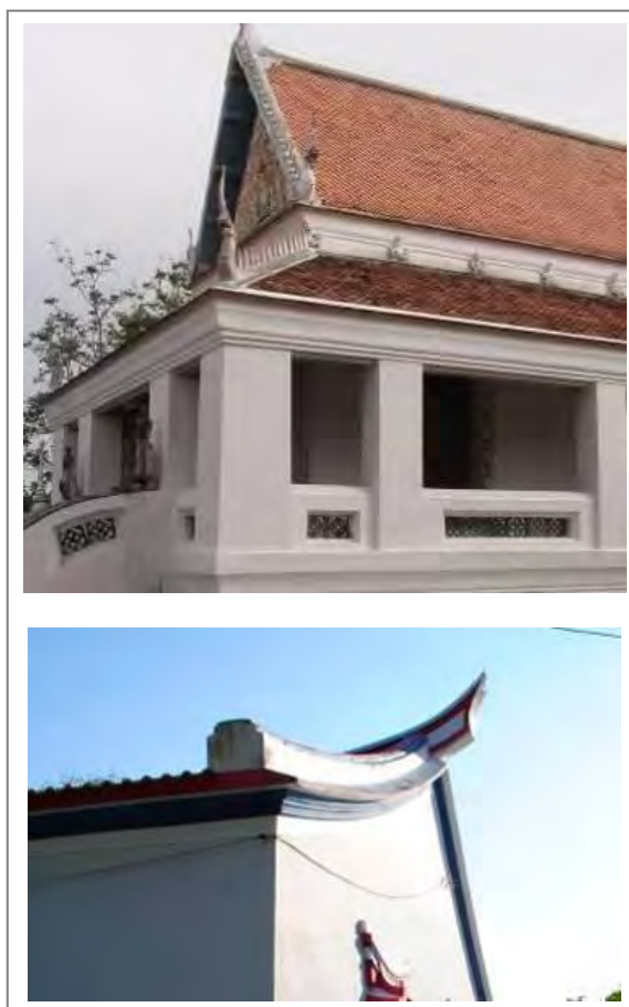
ภาพที่ 75 ชั้นลวดบัวตรงส่วนบนสุดของผนังที่ติดกับชายคาปีกนก พระอุโบสถวัดสลักป่าเก่า และชั้นลวดบัวรับริมหลังคาของพระอุโบสถวัดดอนแย้
