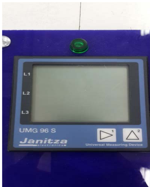
รูปที่ ๓.๓ เจาะรูเพื่อใส่ ติดตั้ง เพาเวอร์มิเตอร์ลงในแผงทดลอง
