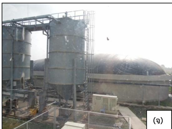
รูปที่ 1.12 : ภาพบริเวณแหล่งกำจัดขยะมูลฝอย เทศบาลนครนครราชสีมา พิกัด 912483 (ก) บริเวณที่ทิ้งขยะฝังกลบ, (ข) เตรียมพื้นที่สำหรับบ่อขยะ, (ค) การปูพลาสติกรอบบ่อขยะป้องกันการไหลซึมลงดิน, (ง) ระบบโรงกำจัดขยะ, (จ) ถังหมักก๊าซเพื่อผลิตไฟฟ้า, และ (ฉ) กากตะกอนขยะที่ใช้ทำเป็นปุ๋ย
