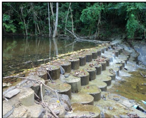
ภาพที่ 50 จุดที่ 2 ทำนบน้ำ
