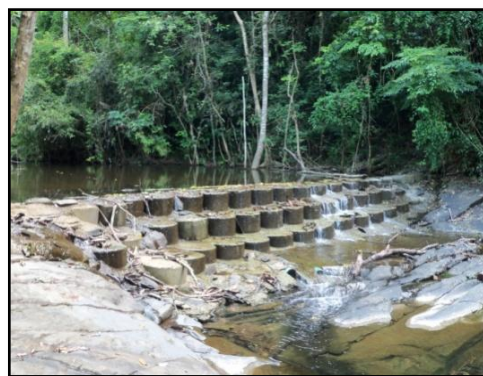
ภาพที่ 29 จุดที่ 2 ทำนบน้ำ
