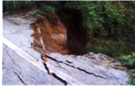
ภาพ 4.1 ลักษณะการเคลื่อนตัวของดินบริเวณถนนทางหลวงในจังหวัดน่าน
