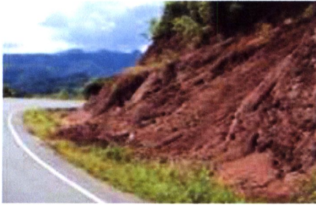
ภาพ 4.1 ลักษณะการเคลื่อนตัวของดินบริเวณถนนทางหลวงในจังหวัดน่าน
