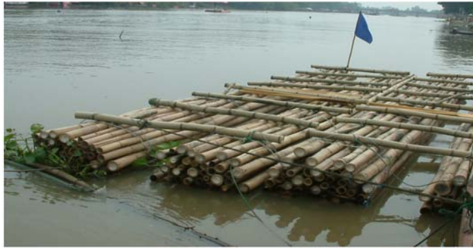
ภาพที่ 10 การจัดระยะลูกบวบ
