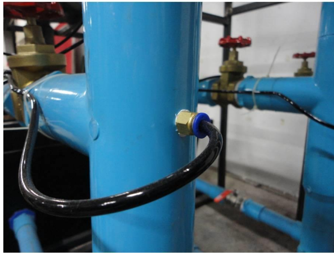
รูปที่ 3.25 การติดตั้งสายวัดความดัน
