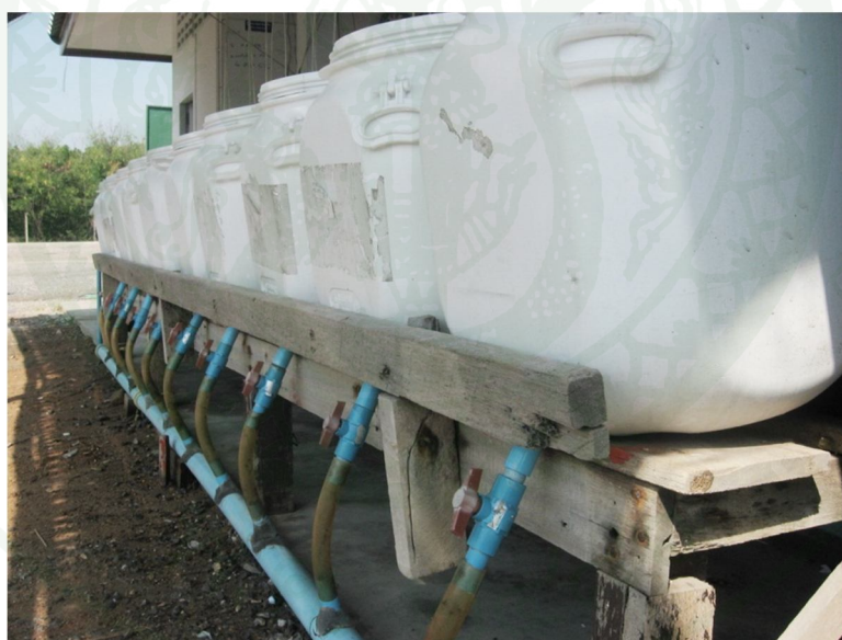
ภาพที่ 31 ท่อสำหรับปล่อยลูกปูลงทะเลเมื่อฟักแล้ว
