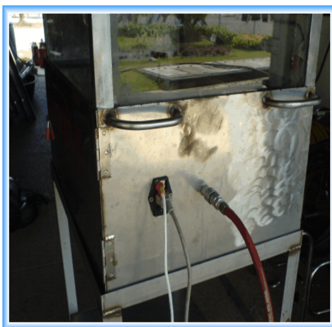
ภาพที่ 26 แสดงตำแหน่งการต่อสายจาก ตัวควบคุมและสายเชื่อมเพลิงเข้ากับตัวตู้สาริต
