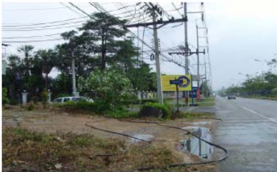
ภาพที่ 13 สาย SAC ขนาด 3 เฟสตรงตำแหน่งบน Porcelain spacer เคลือบเซรามิก
