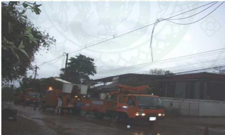
ภาพที่ 14 สาย SAC ขนาด 2 เฟสตรงตำแหน่งบน Porcelain spacer เคลือบเทปลอน
