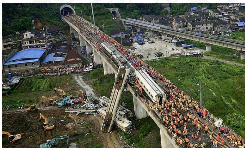
ภาพที่ 23 แสดงภาพหลังอุบัติเหตุรถไฟฟ้าแบบโครงสร้างยกระดับชนกันเพราะไฟฟ้าลัดวงจร หลังถูกฟ้าผ่า
