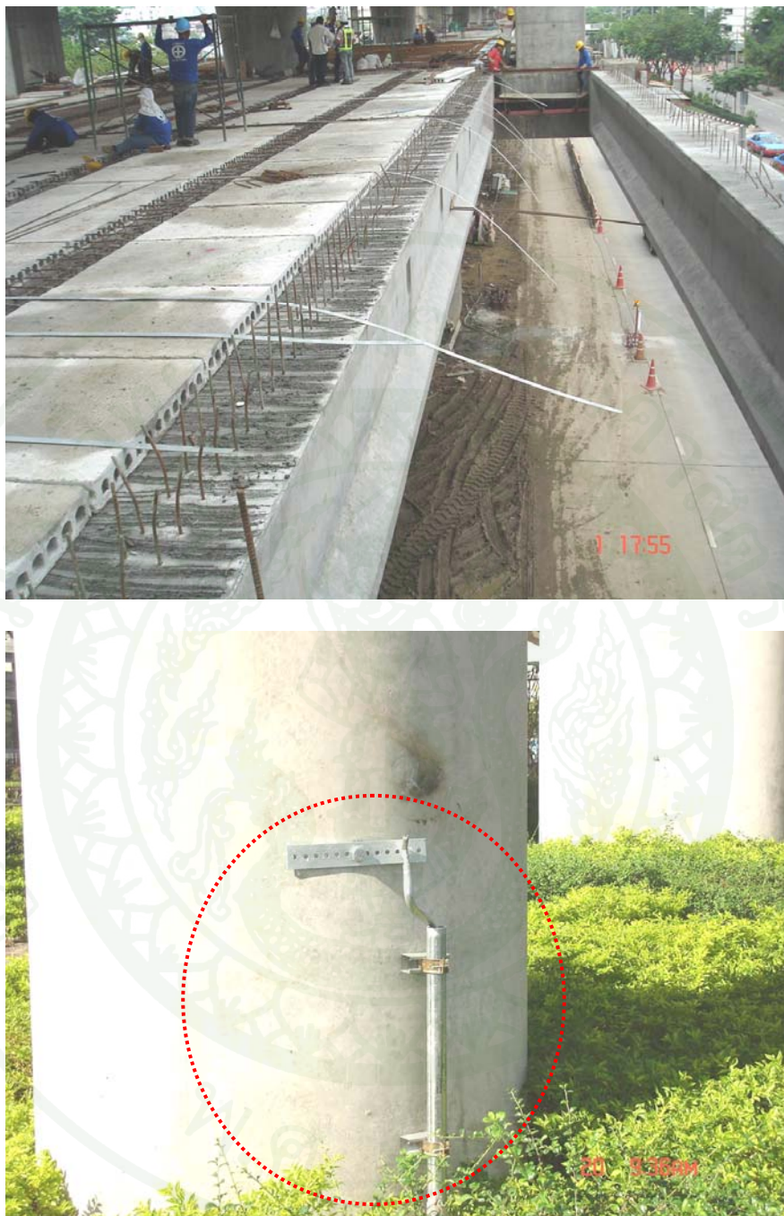
ภาพที่ 15 Bare copper และกราวด์เดี่ยว ของสถานีรถไฟฟ้าแบบโครงสร้างยกระดับ
