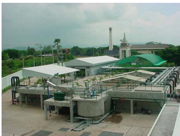
ภาพที่ 31 โรงบำบัดน้ำเสียเทศบาลเมืองลำพูน
