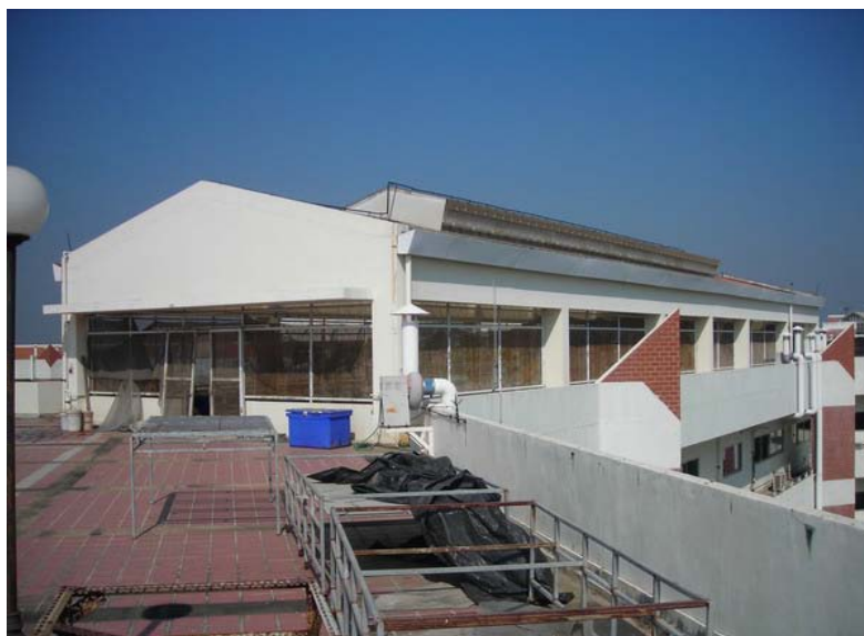
ภาพที่ 8 โรงเรือนหลังคา อะครีลิก ขนาด 12x40 เมตรที่ใช้ในการทดลอง
