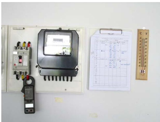
รูปที่ 3.17 เครื่องมือในการเก็บข้อมูลหน่วยการใช้กระแสไฟฟ้าที่ กิโลวัตต์/ชั่วโมงประจำห้อง
