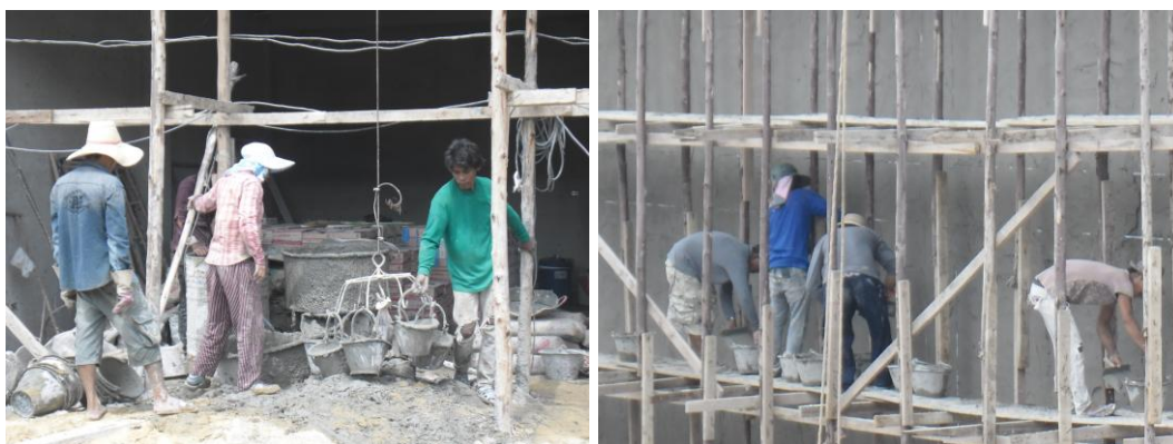
รูปที่ 4.11 สภาพแวดล้อมในการทำงานฉาบปูนผนังภายนอกอาคารก่อนนำระบบความปลอดภัยมาใช้
