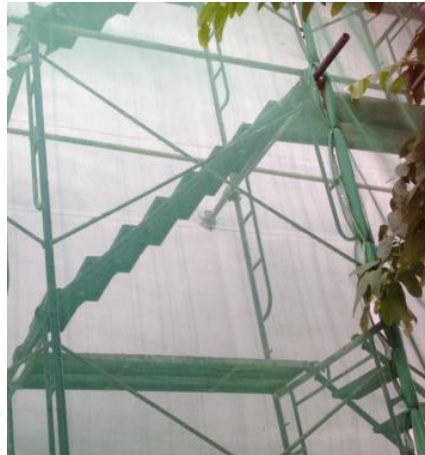
รูปที่ 4.8 ติดตั้งบันไดขึ้น – ลง สำหรับทำงาน
