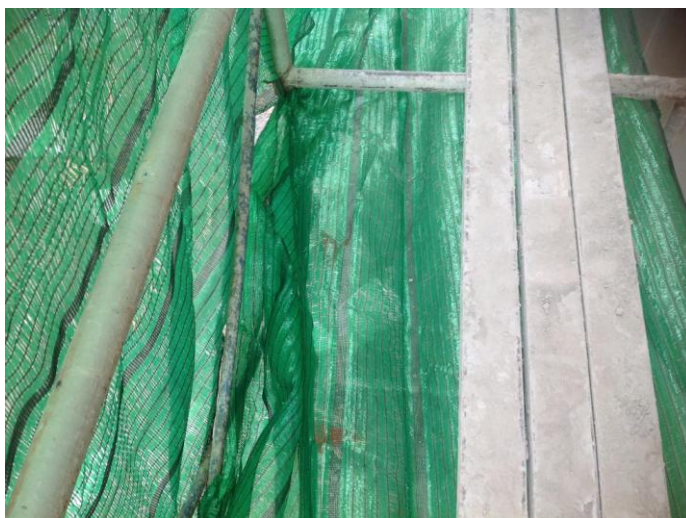
รูปที่ 4.4 ทางเดินบนนั่งร้าน สะอาด ไม่ลื่น และการติดตั้งตาข่ายป้องกันอันตรายต่อผู้ทำงานอยู่ด้านล่าง
