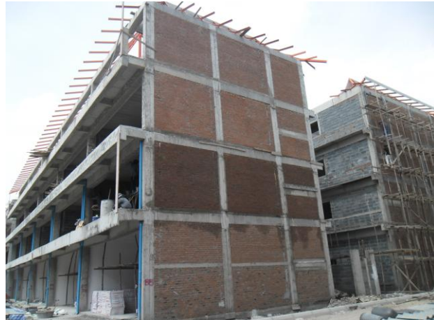
รูปที่ 4.2 พื้นที่ในการทำงานฉาบปูนผนังภายนอกอาคาร
