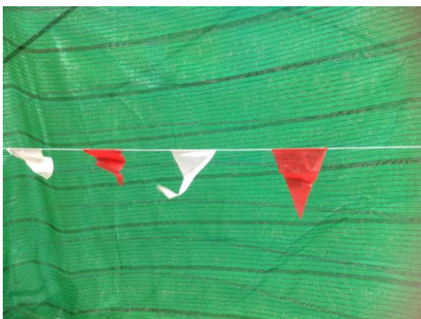
รูปที่ 4.7 กั้นเขตด้วยธงราว หรือแถบขาวแดง แสดงเขตพื้นที่ทำงาน
