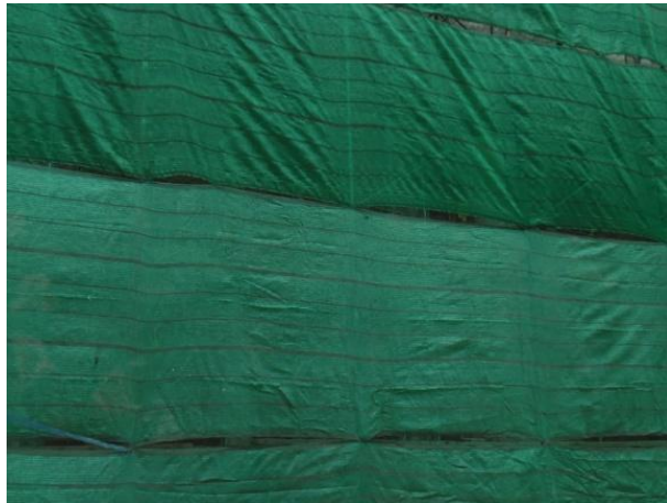
รูปที่ 4.6 ติดตั้งตาข่ายรอบนอกของนั่งร้าน
