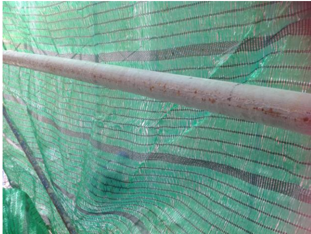
รูปที่ 4.5 ติดตั้งราวกันตกสูงไม่น้อยกว่า 0.90 เมตร
