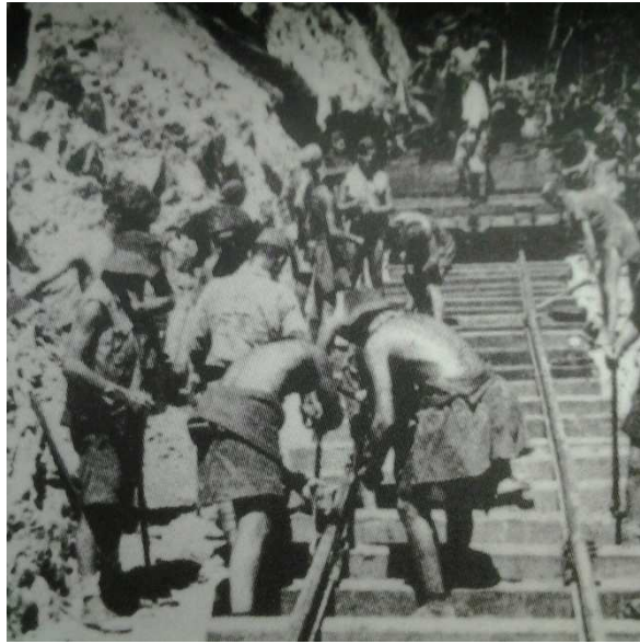
ภาพที่ 15 การก่อสร้างทางรถไฟโดยเชยศึกษาฝ่ายพันธมิตร ที่มา: Australian Government (2015)
