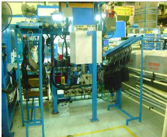
ภาพที่ 70 งานระหว่างทำของท่อส่งน้ำมันในกระบวนการผลิต (หลังการปรับปรุง)
