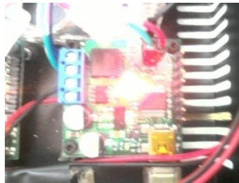
รูปที่ 5.17 การติดตั้งบอร์ด Polulu ลงบนกล่อง Control
