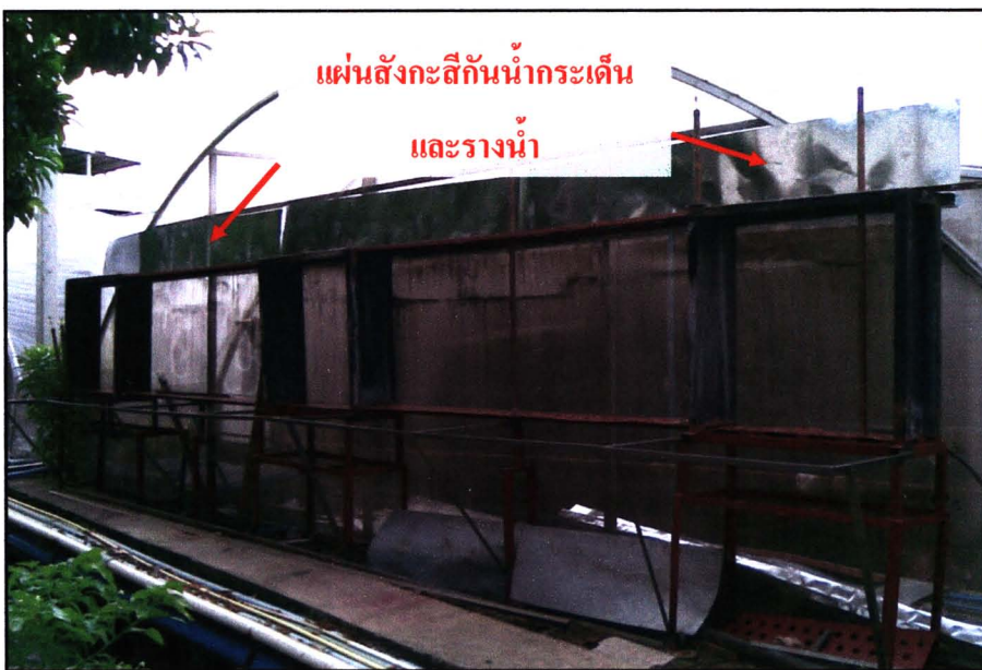
รูป 3.12 ติดตั้งแผ่นสังกะสีกันน้ำกระเด็นและรางน้ำ
