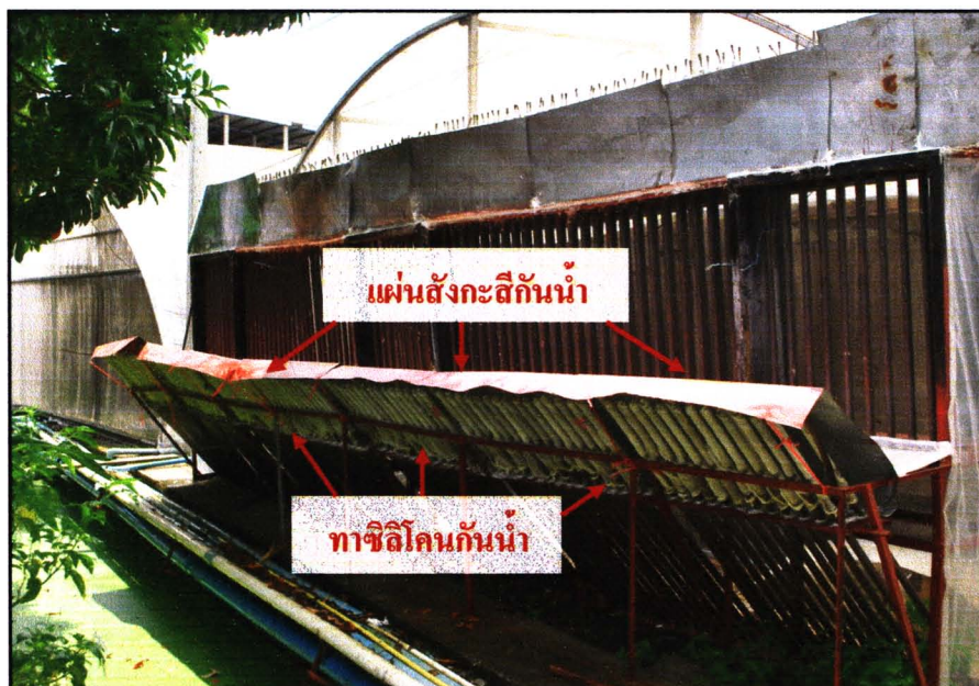
รูป 3.20 ติดตั้งแผ่นสังกะสีและทาสีลิโคนกันน้ำไว้ชุดด้านล่าง
