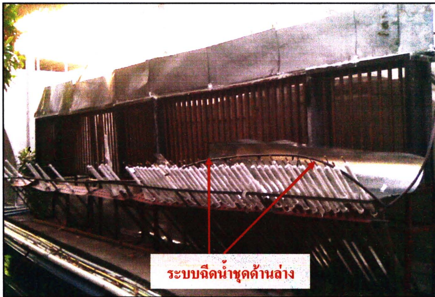
รูป 3.19 ติดตั้งท่อความร้อนและระบบฉนวนน้ำชุดด้านล่าง
