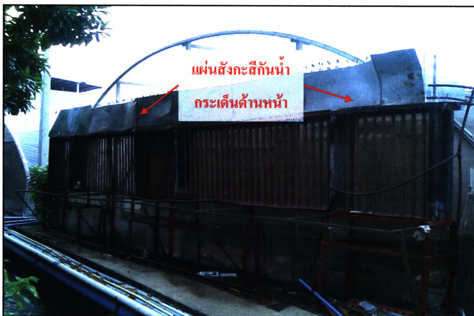
รูป 3.16 ติดตั้งแผ่นสังกะสีก้นน้ำกระเด็นด้านหน้า
