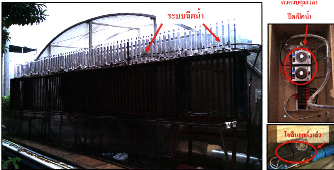
รูป 3.15 ติดตั้งระบบฉนวนระบายความร้อนและระบบควบคุมเปิดปิดน้ำ
