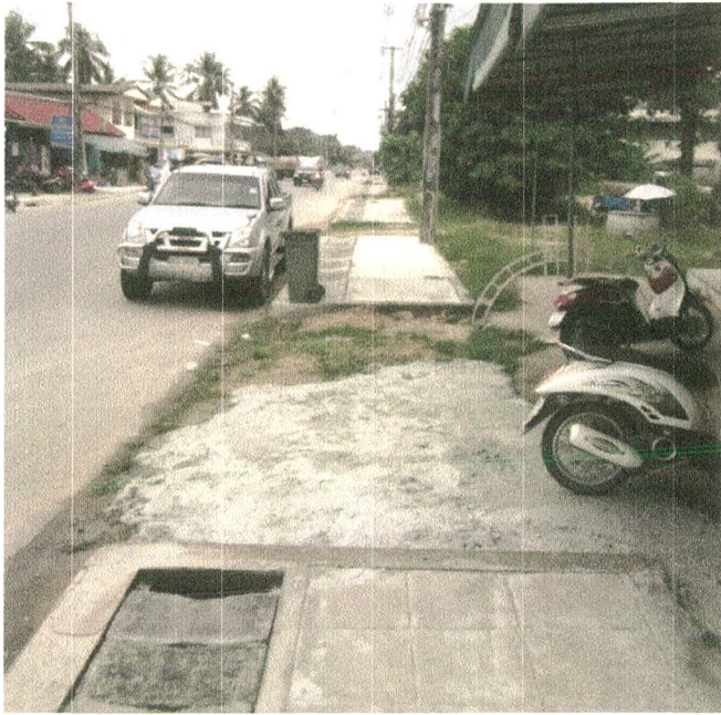
ทางเดินเท้าก่อนการปรับปรุง
