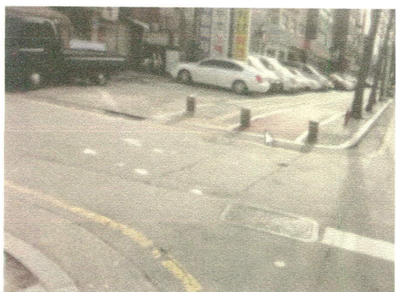
รูปที่ 2-45 การยกระดับพื้นผิวถนนบริเวณทางแยกให้มีระดับเดียวกับทางเดินเท้า ที่มา: Lee (2556, อ้างใน สาขาวิชาการวางผังเมืองและสภาพแวดล้อม, 2556)
