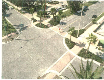
รูปที่ 2-30 การขยายทางเดินเท้าบริเวณทางแยก ที่มา: Project for Public Spaces (2008)
