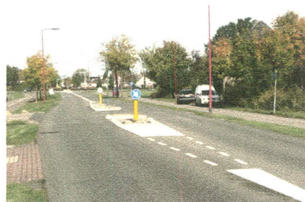
ทางข้ามแบบมีเกาะพักกลางถนน (Pedestrian refuge) เนเธอร์แลนด์ ภาพโดย : Bart Lambregts
