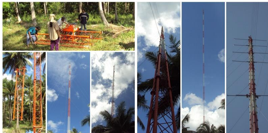
รูปที่ 3.36 การยกเสาแต่ละท่อนสำหรับการติดตั้ง
