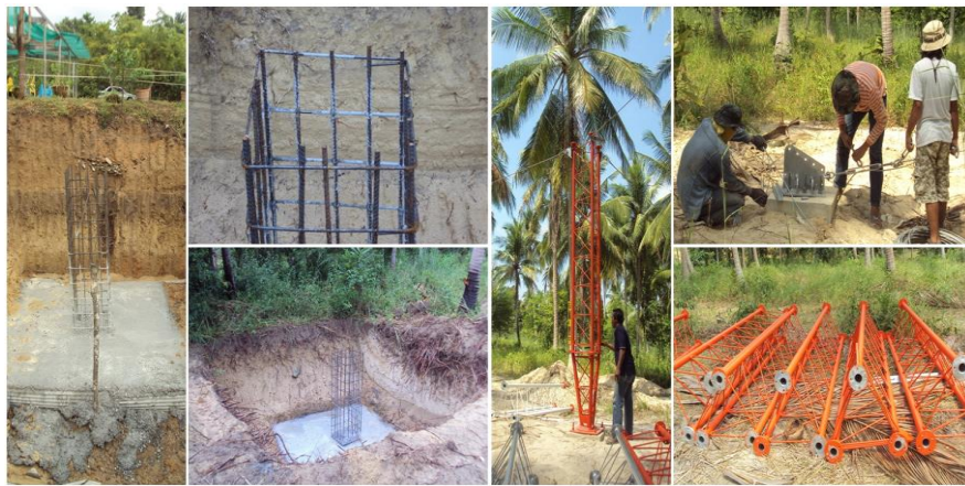
รูปที่ 3.35 การเทปูนทำฐานรากและการติดตั้งเสาวัลคัม
