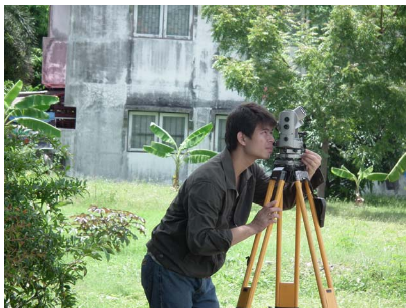
รูปที่ ก.9 การตรวจสอบการติดตั้งเสาและเครื่องมือวัด ที่ มหาวิทยาลัยบูรพา ต. แสนสุข อ.เมือง จ. ชลบุรี
