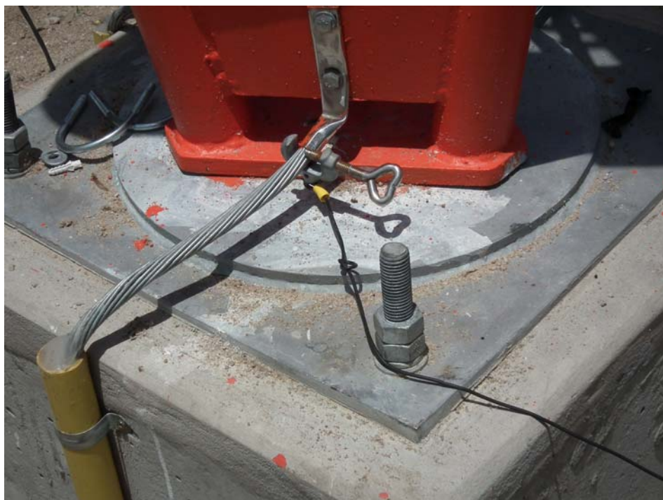
รูป ก.17 ตัวอย่างการติดตั้งเครื่องวัดค่าความต้านทานดิน
