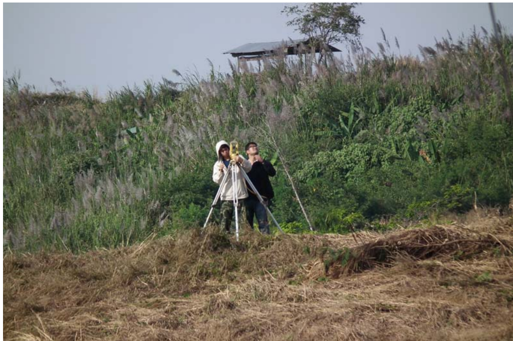
รูปที่ ก.11 การตรวจสอบการติดตั้งเสาและเครื่องมือวัด ที่ ต.ทับไทร อ.โป่งน้ำร้อน จ.จันทบุรี
