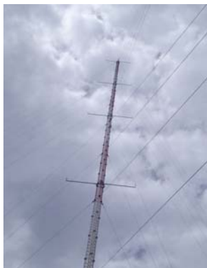
อุปกรณ์วัดความเร็วและทิศทางลมทั้ง 4 ระดับ
