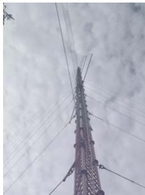
อุปกรณ์วัดความเร็วและทิศทางลมทั้ง 4 ระดับ
