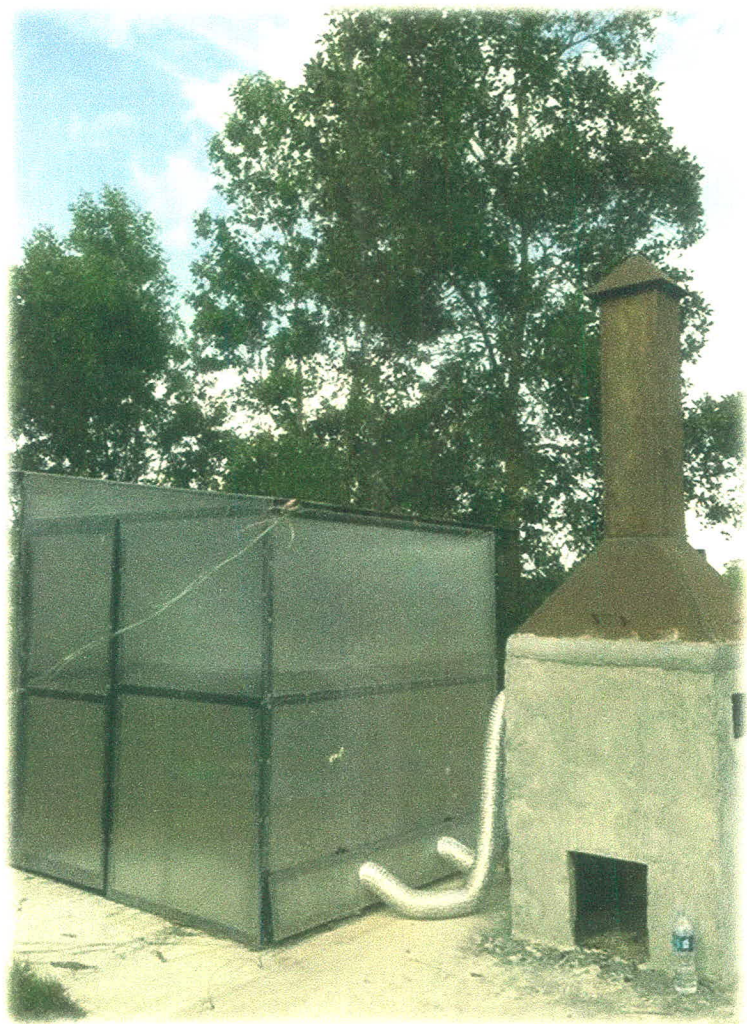
รูปที่ 3.4 ระบบให้ความร้อนพลังงานชีวมวล
