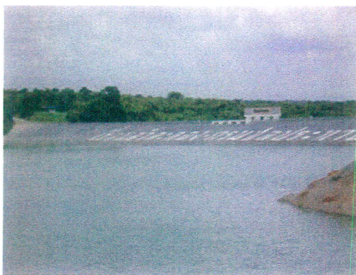
ภาพที่ ก6 การใช้ stop logs กันด้านหน้าอาคารระบายน้ำล้นเพื่อเพิ่มระดับเก็บกักของเขื่อนลำตะคอง
