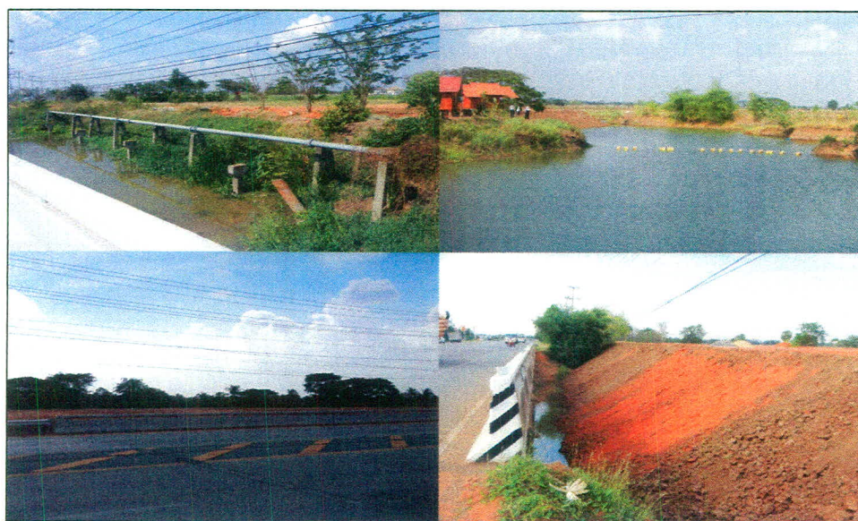
รูปที่ 4.3-2 สภาพปัญหาการถมดินปิดช่องสะพาน
