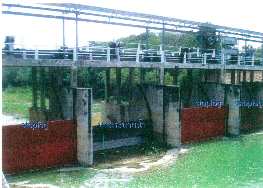
รูปที่ 2.6-1 การวาง Stop log ด้านหน้าของช่องบานระบายน้ำล้นของเขื่อนลำตะคอง
