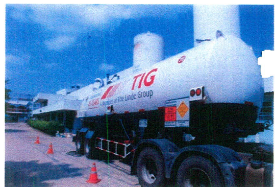
ออกซิเจนเหลวติดตั้งถังเพิ่มอีก 1 ถัง เต็มเต็ม อยู่ได้ 2 สัปดาห์
