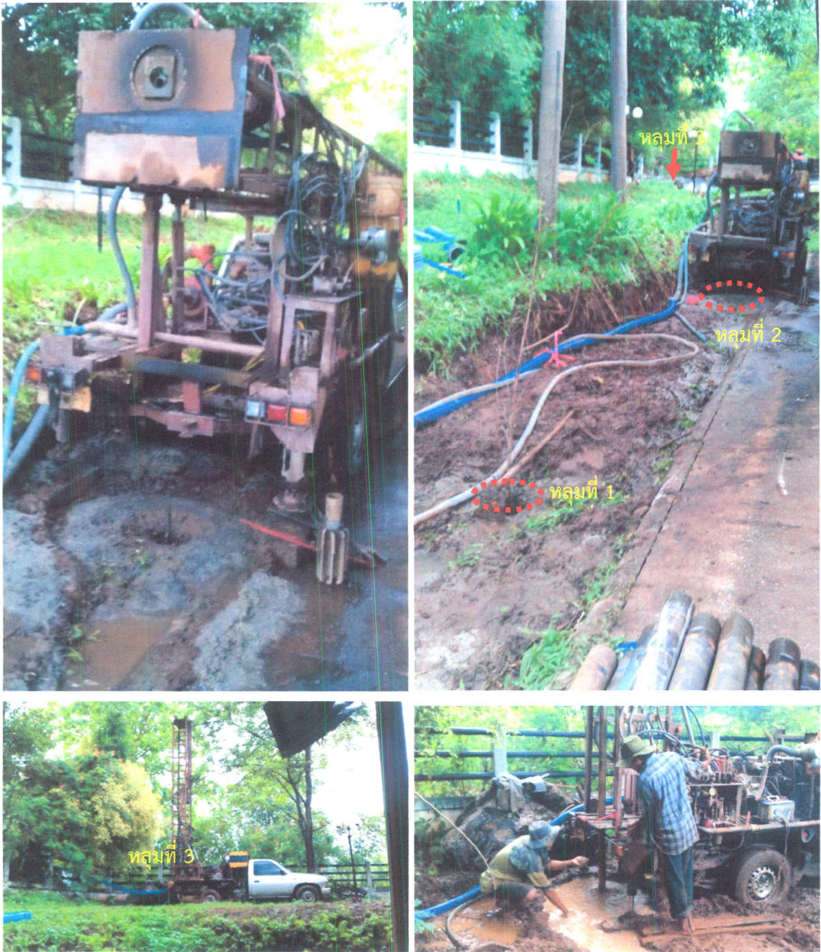
ภาพที่ 4-32 ตำแหน่งการเจาะน้ำใต้ดินทั้งหมด 3 ตำแหน่งและการวางเครื่องเจาะซึ่งเจาะที่ 3 เมื่อการขยับเปลี่ยนตำแหน่งหลายครั้งเนื่องจาก พบชั้นตะกอนเศษหินเชิงเขาไม่สามารถเจาะต่อได้
