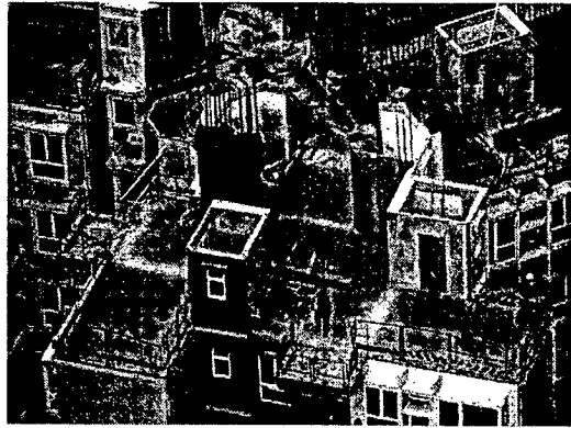
ภาพที่ 2.10 แสดงระบบชั้นส่วนสำเร็จรูประบบกล่อง โครงการ ONE CENTRAL, MACAU 2006 ที่มา : ปรับปรุงจาก สามชัย รมทอง และ อานนท์ นันทฤทัย (2547)
