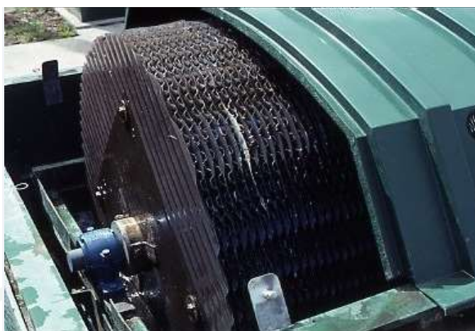
ภาพที่ 11 ระบบแผ่นหมุนชีวภาพ (Rotating Biological Contactor)
