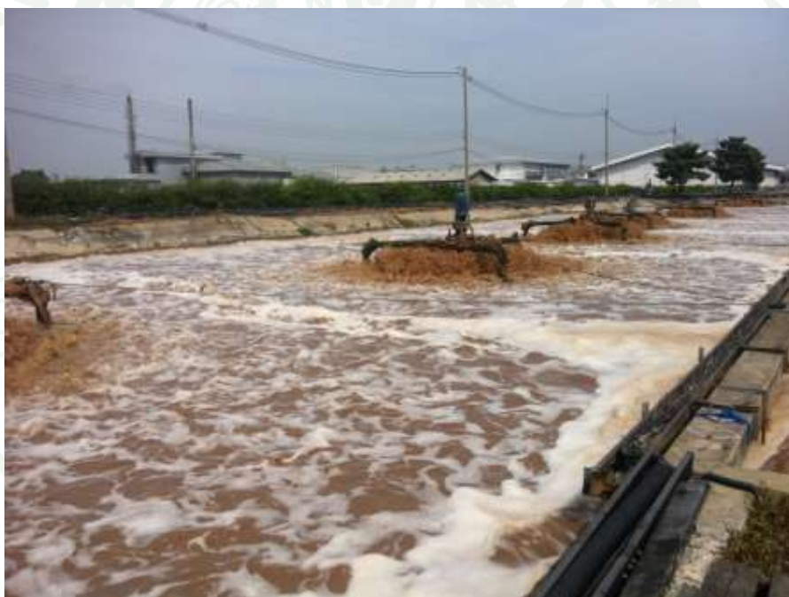
ภาพผนวกที่ ค2 บ่อเลี้ยงตะกอนที่ทำการเก็บเชื้อตะกอนจุลินทรีย์
