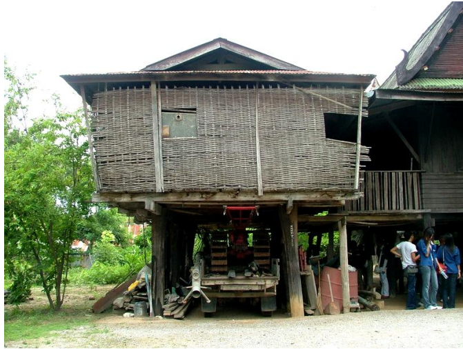
ภาพที่ 149 เล้าข้าวขนาดใหญ่ ฝากระเบื้องเป็นฝาไม้ไผ่ขัดตะ
