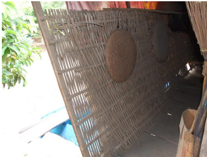
ภาพที่ 102 ฝากระเบื้องทำด้วยไม้ไผ่ขัดแตะของเจ้าของเรือนในกรณีศึกษาที่ 4
