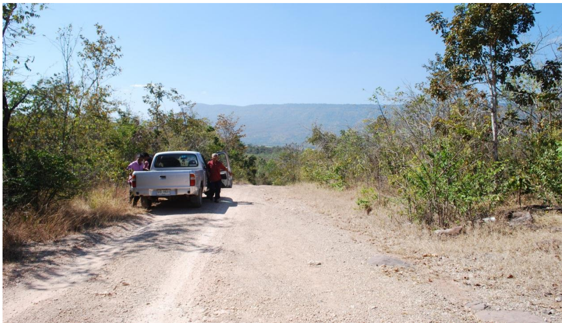
ภาพที่ 16 ลักษณะถนนที่เข้าถึงป่าภูกระแต เป็นถนนสายเดิมจากยุคสัมปทานป่า
